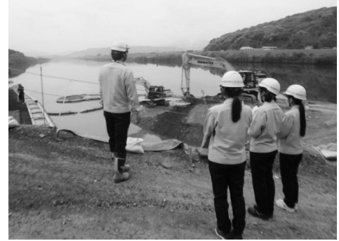
現場パトロール 現場の状況や危険箇所等を確認
